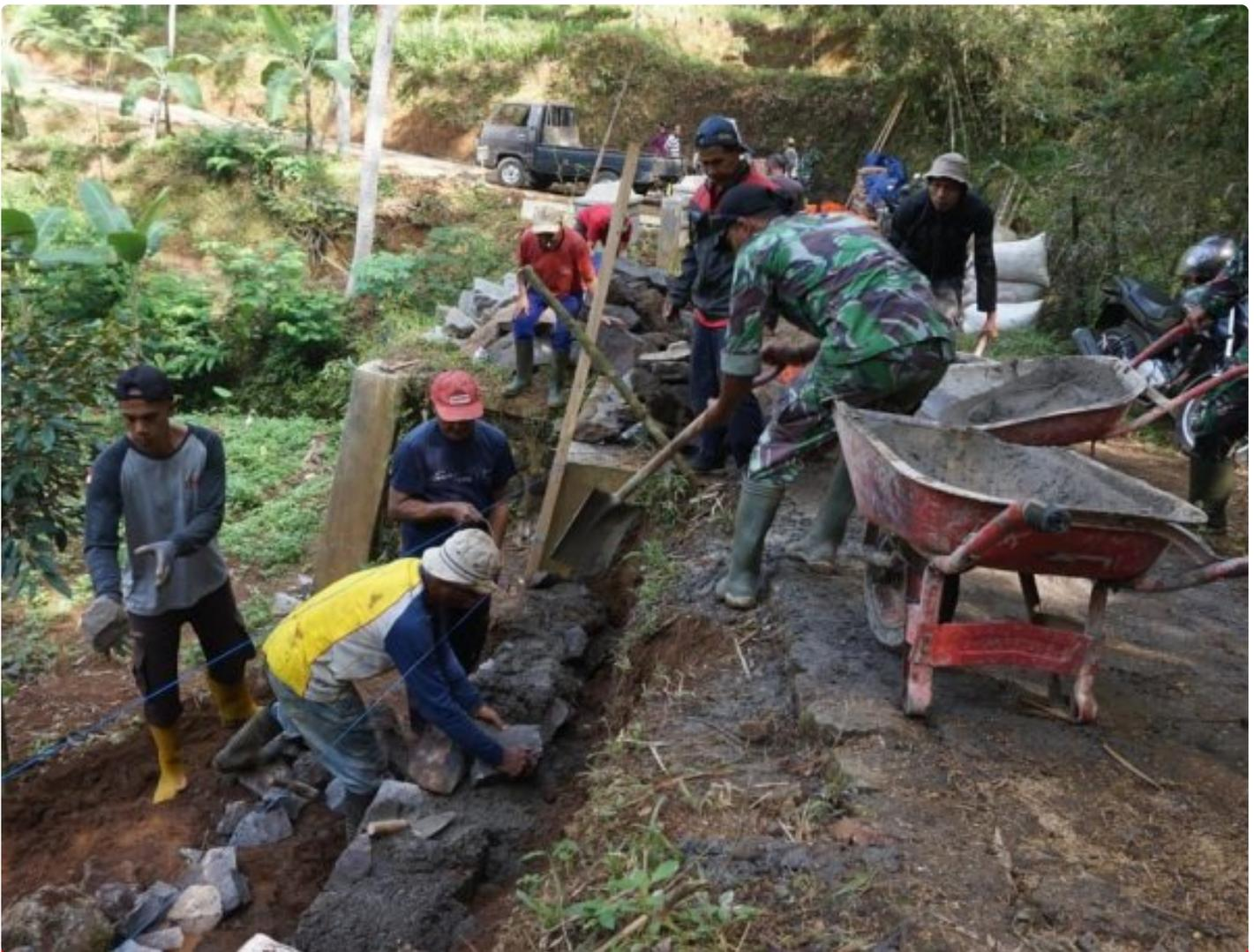
*Dalam rangka pelaksanaan TMMD Reguler ke-120 Kodim 0707/Wonosobo mulai membangun senderan jalan sepanjang 89,5 meter dengan tinggi rata – rata 1,5 meter yang terbagi menjadi 4 titik. (19/5/2024)*
